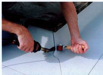
ХОТ-ДЖЕТ S при сварке кровельного покрытия из ПВХ около фонаря. Легкий, весом 580 г, аппарат используется для сварки углов, примыканий, накладок и т.д.
