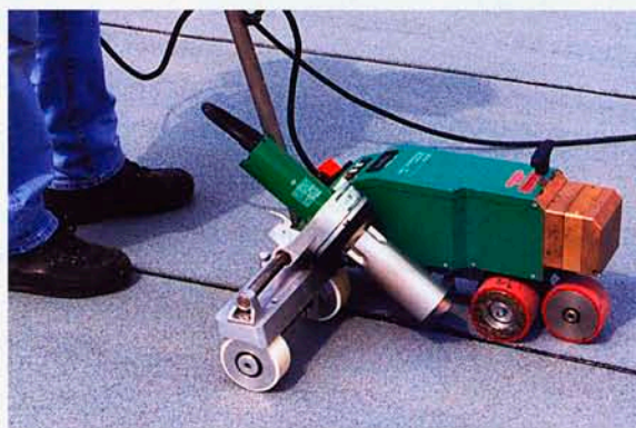
Сварочный автомат ВАРИМАТ при сварке битумных кровельных покрытий.
