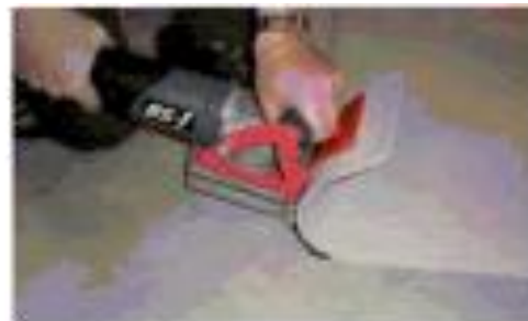
Снятие одной полосы ПВХ.
